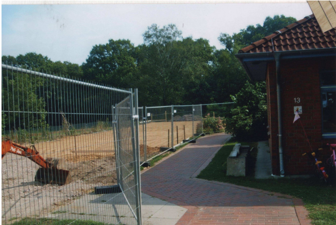
Samenkorn im Bau...
